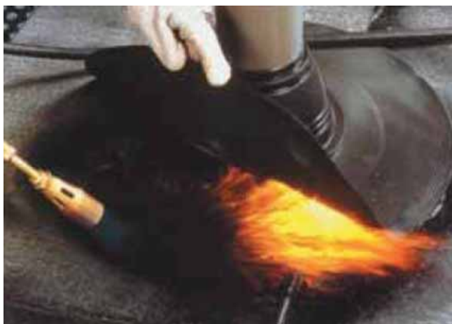
Fot.18 Obróbka rury
