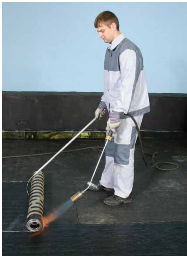
Fot. 14 Układanie papy MIDA REMONT SUPER
